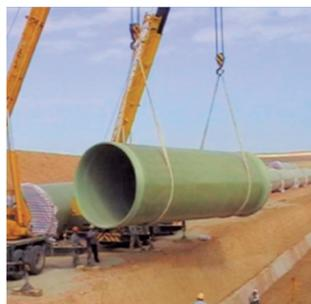
Tubería que se utilizará en el Emisario, diámetro de 1.6 a 1.8 m.
