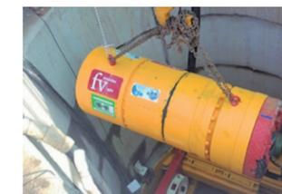
Micro tuneladora para perforación horizontal dirigida (pipe jacking).
